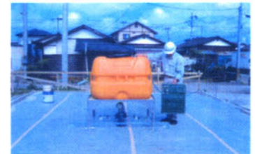
[ジオクロス施工後の載荷試験]
