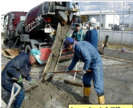
シューターから打設
