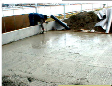
打設後の押えならし
