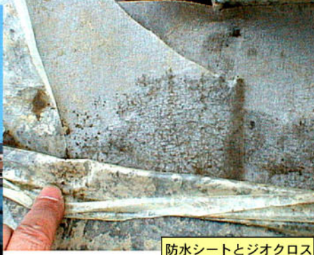
防水シートとジオクロス
